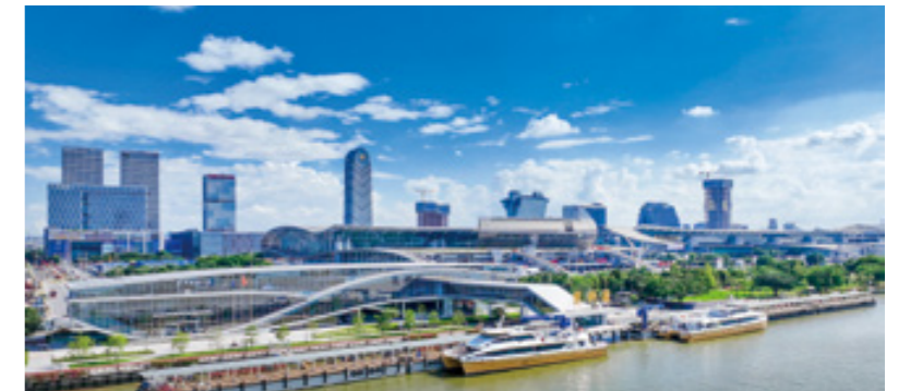
琶洲港澳客运码头
