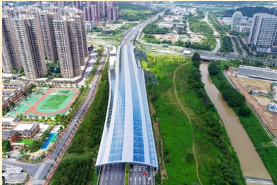
越秀交通北二环高速建设项目
